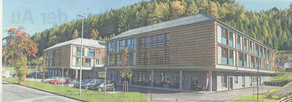
Die beiden in einem Gebäudekomplex unterbrochenen Höfe sind räumlich und funktionell eigenständig.
